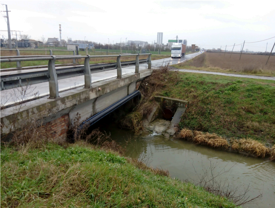
Ponte su Canale Diversivo In Valle
