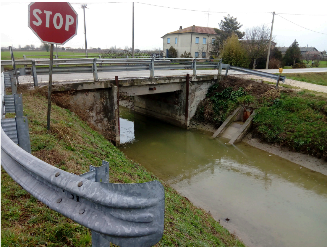
Ponte su Canale Fossatone Nuovo
